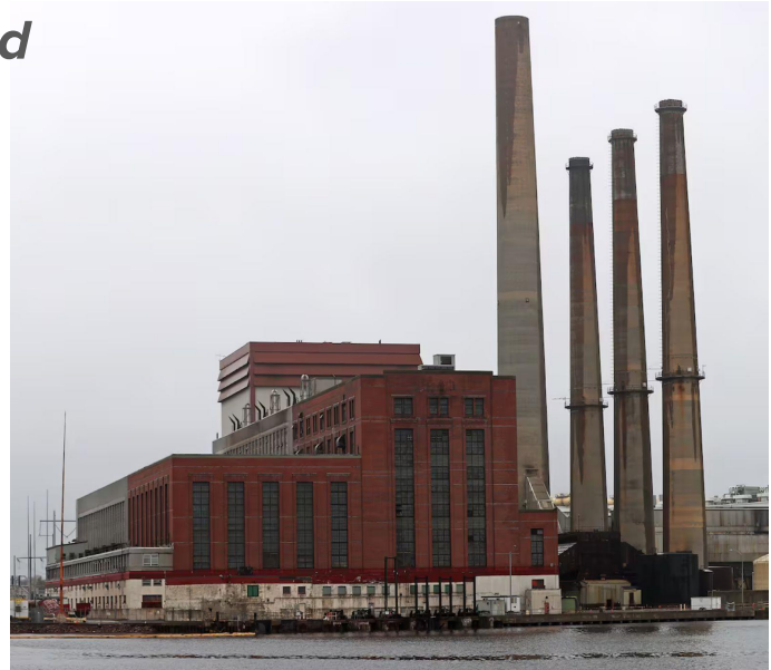
Everett Marine LNG Terminal
